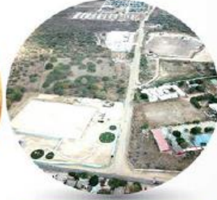
VÍA TRANSVERSAL DEL SUR, INVERSIÓN: $47.681 millones
